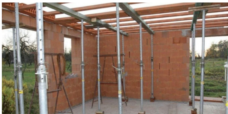
Obr. 11 Podopretie nosníkov na stavbe
