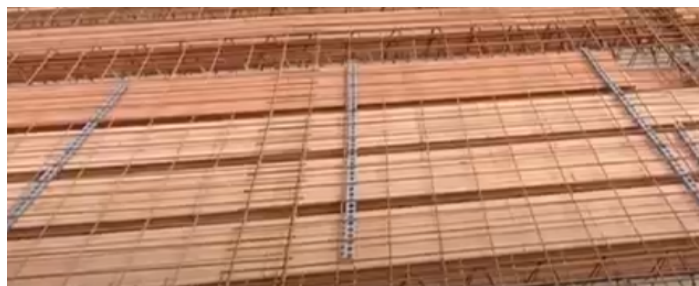
Obr. 20 Rozloženie zváraných sietí na dištančné lišty
