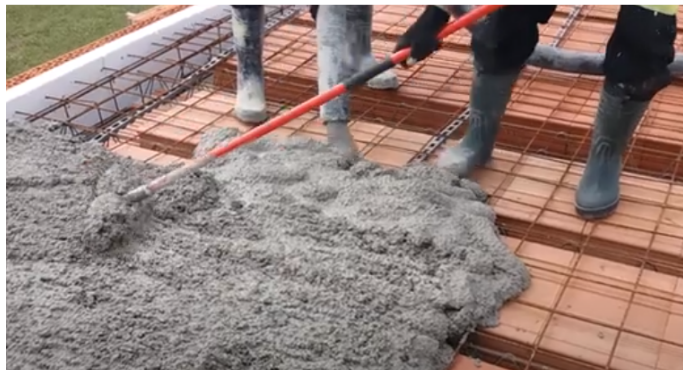
Obr. 30 Betónovanie stropnej konštrukcie
