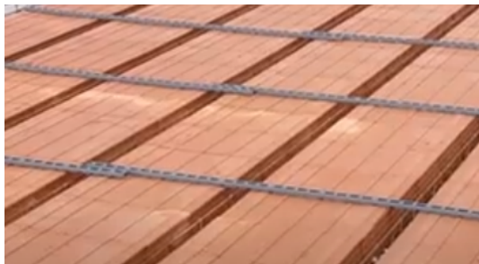
Obr. 19 Dištančné lišty rozmiestnené po MIAKU
