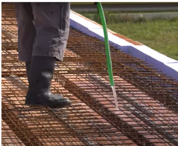
Obr. 29 Navlhčenie MIAKA pred betónovaním
