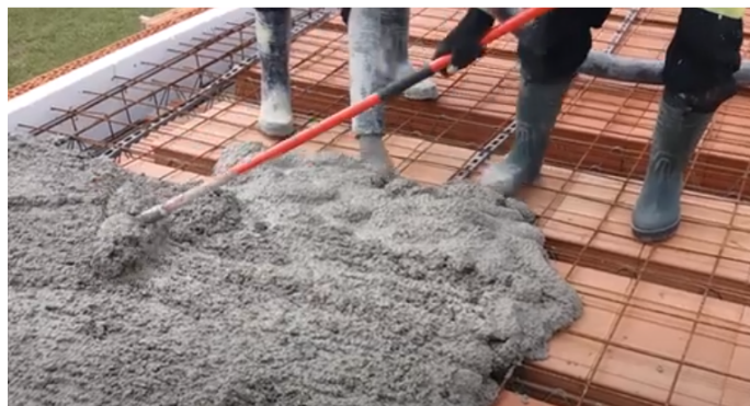
Obr. 33 Betónovanie stropnej konštrukcie
