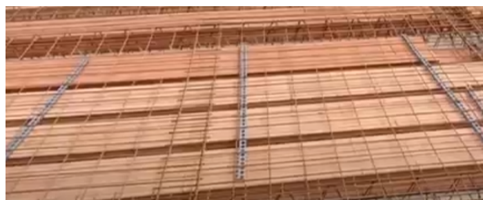
Obr. 23 Rozloženie zvaraných sietí na dištančné lišty
