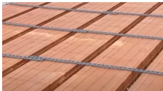
Obr. 22 Dištančné lišty rozmiestnené po MIAKU
