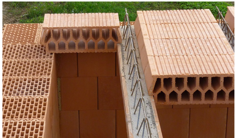
Obr. 16 Uloženie MIAKA na nosnú stenu priamo na stavbe
