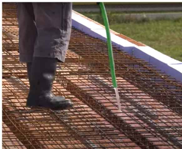
Obr. 32 Navlhčenie MIAKA pred betónovaním
