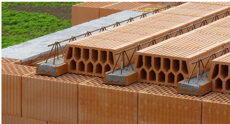
Obrázok 17 – MIAKÁ pred nalepením Styroduru
