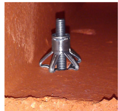
Obrázok 37 – Pohľad do vnútra keramickej stropnej vložky MIAKO
