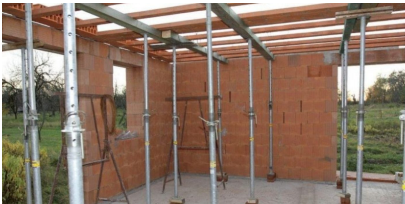
Obr. 11 Podopretie nosníkov na stavbe
