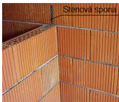
Obrázok 11 – Zamurovanie stenovej spony počas murovania priečky
