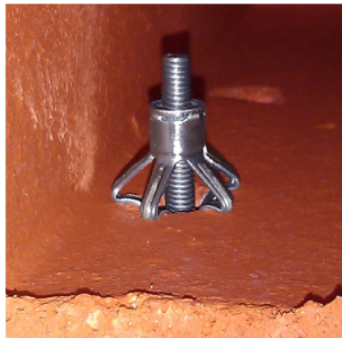
Obrázok 26 – Pohľad do vnútra keramickej stropnej vložky MIAKO
