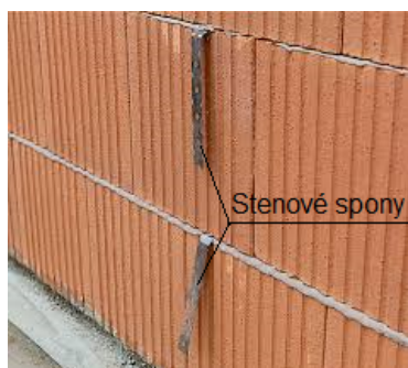
Obrázok 9 – Zamurovanie stenových spôn
