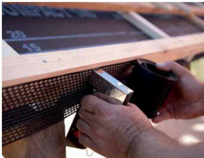
Inštalácia perforovanej odvetrávacej pásky
