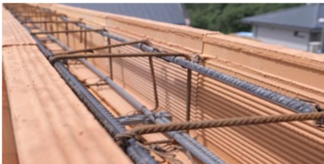
Obrázok 2 – Uloženie výstuže do vnútorného priestoru strateného debnenia
