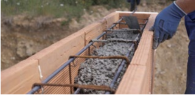
Obrázok 3 – Betónovanie vnútorného priestoru strateného debnenia
